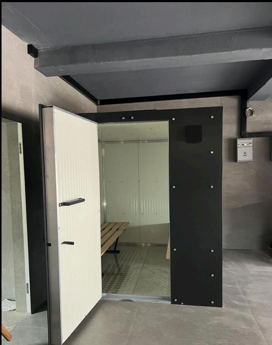
Aménagement intérieur : bancs de secours et sol larmé en acier antidérapant
